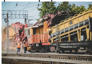
а- замена балластного слоя на главных путях
