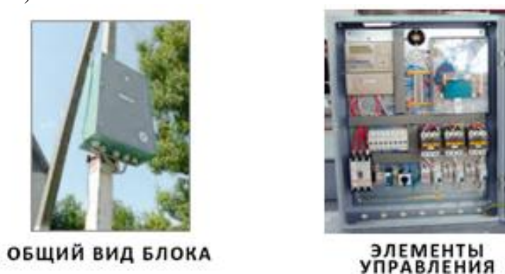
Рисунок 1 – Общий вид автоматизированной системы управления наружным освещением
