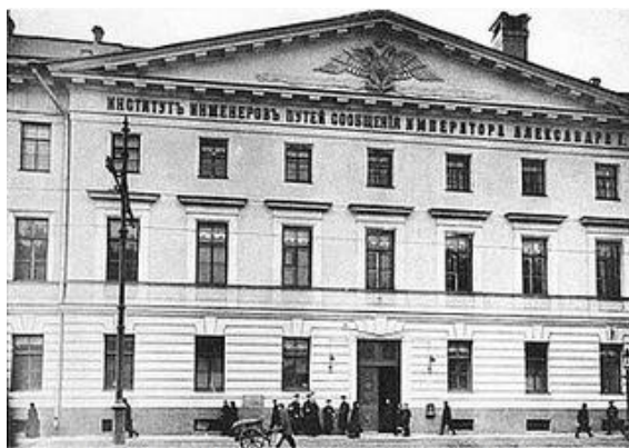
Здание института инженеров путей сообщения
