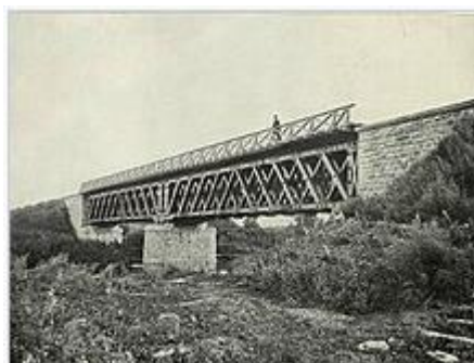
Мост системы Гау через Лебяжью реку на Транссибе, 1899
